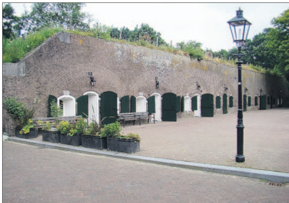
Komende zaterdag is er een bijzonder programma op Fort Blauwkapel. Inmiddels is de renovatie van het wachthuis en de bomvrije kazerne afgerond.
